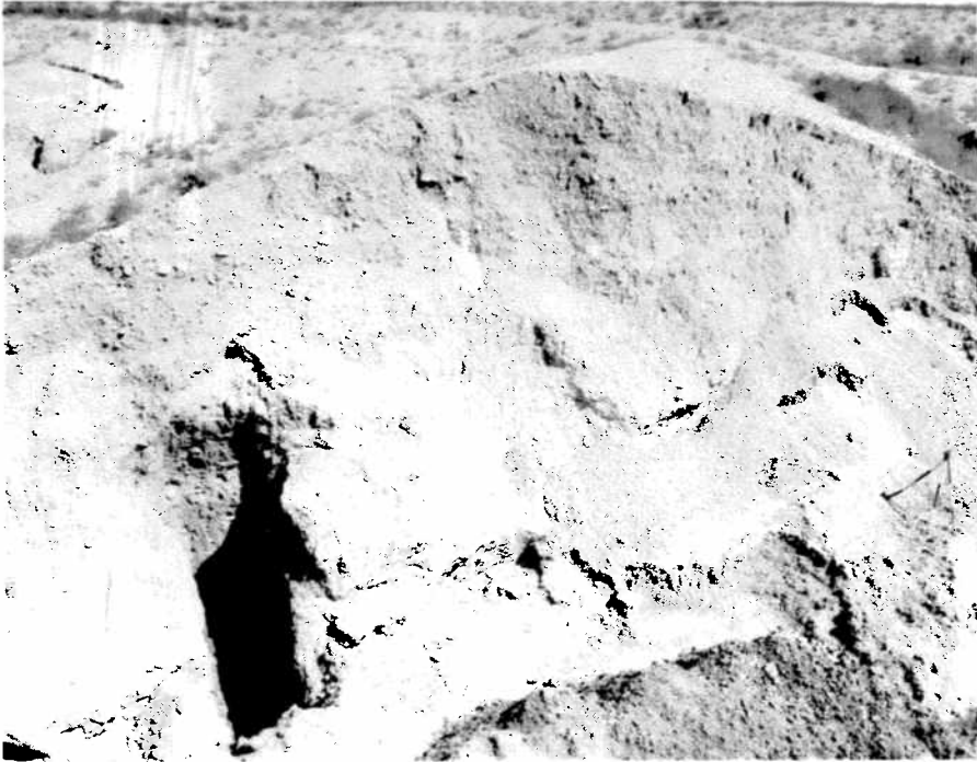
3. Looking east face Sta. 3+00±.
